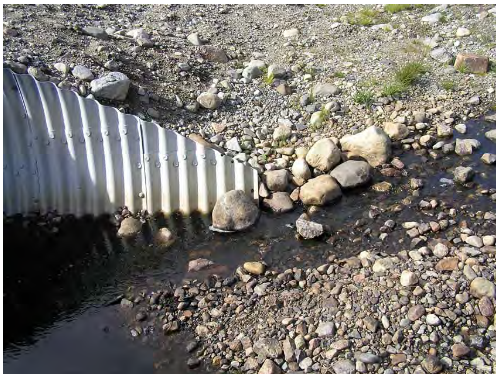
Figur 129. Vid kanten av denna nedgrävda heltrumma har högvatten eroderat. Det är mycket viktigt att erosionssäkra genom att lägga större sten (eventuellt krossten) vid kanten, alternativt gjuta en betongkrage vid sådana här ställen. Gjuts en betongkrage minskar också risken att skräp och grenar fastar uppströms trumman, men i gengäld ökar vattenhastigheten i trumman något. Foto: Erik Degerman.
