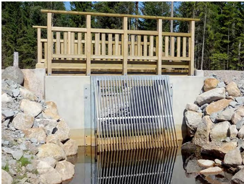
Figur 74. Ett rejält gjutet utlopp säkrar både möjligheten till reglering och att inte fisk tar sig upp i sjön. Foto: Erik Degerman.
