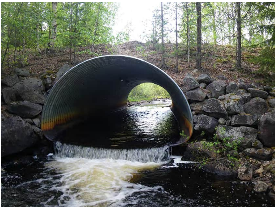
Figur 130. Bra med oval heltrumma, men gräv ned den så att den följer vattendragets bottenprofil och får ett naturligt bottensubstrat. Foto: Pierre Samuelsson.
