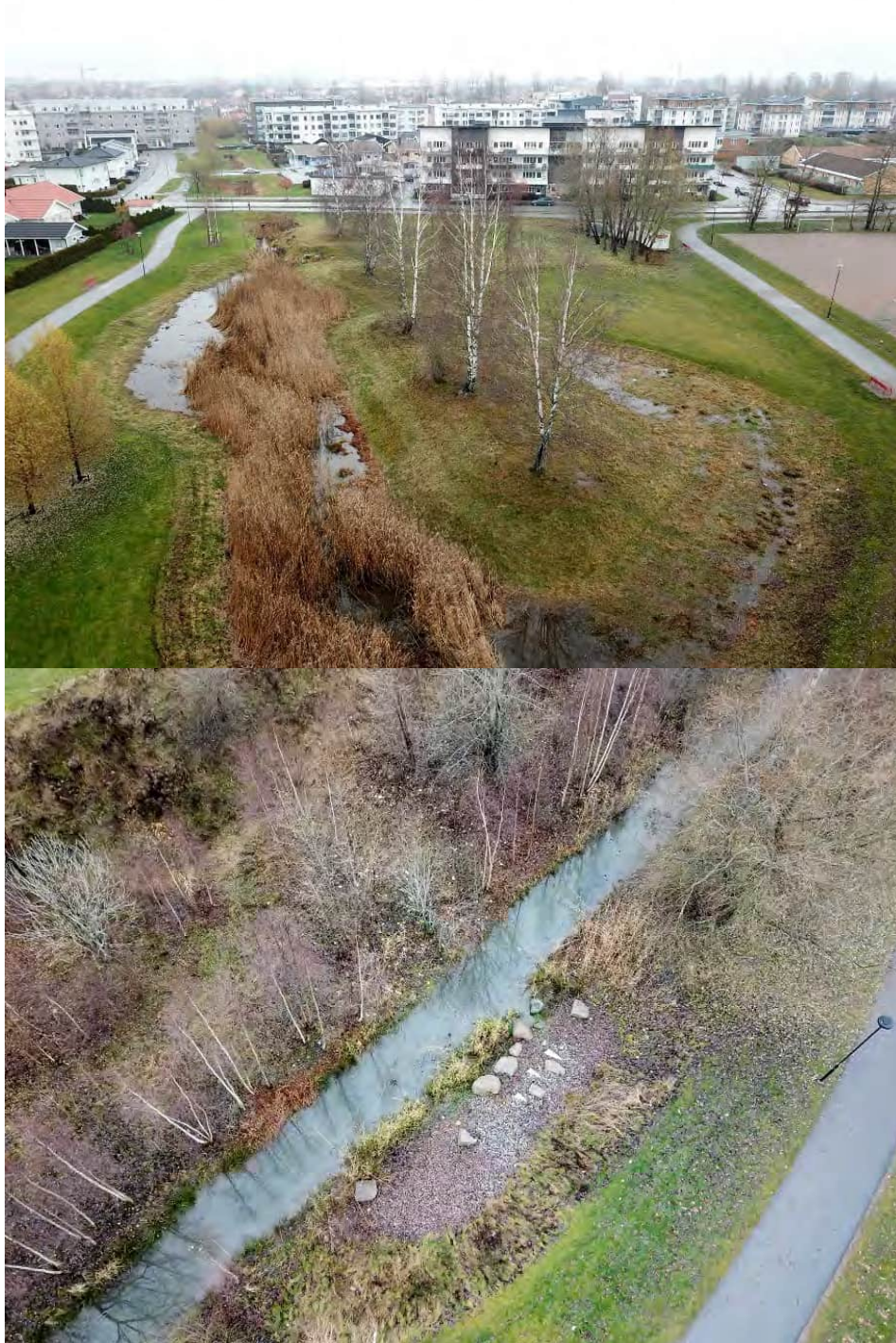
Figur 80. Åtgärder för att låta vattnet ta plats vid högflöden i Örebro kommun. Övre bild: en parallell sidofåra har skapat för att ta emot vatten vid högflöden. Nedre bild: Avfasade stränder som hårdgjorts för att ta emot och bromsa vatten vid högflöden. Foto: Erik Degerman.
