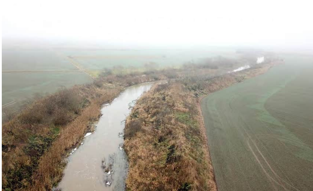
Figur 135. Täljeån på Närkeslätten rätades och kanaliserades och heter numer Kvismare kanal. De massor som grävs ur vattendraget läggs successivt på strandvallen och vattendraget blir djupare och förlorar kontakten med det allt högre och avlägsnare svämplanet. Foto: Erik Degerman.
