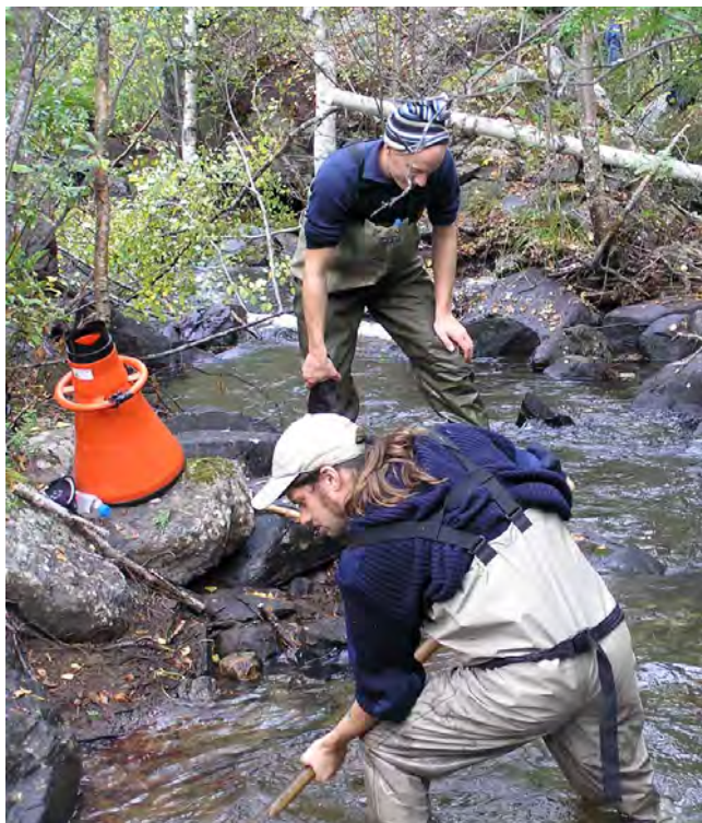
Figur 170. Etablering av lekbotten enligt Hartijoki-metoden. Uppströms grävs och sällas lekgrus fram och läggs sedan precis nedom forsacken nedströms. Vid forsacken har ett antal större stenar/block lagts för att hålla kvar lekgruset. Joel i bakgrunden står på dessa stenar/block. Foto: Erik Degerman.
