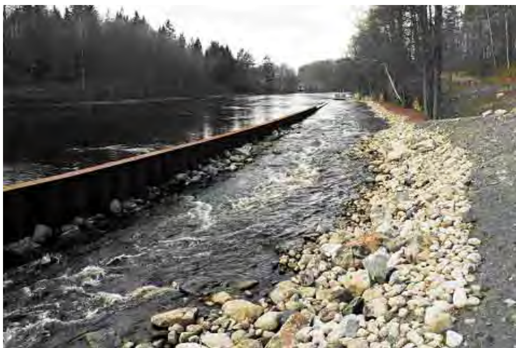
Figur 121. Hemsjö övre fiskväg anlagd som ett inlöp parallellt med Mörrumsån. Stålspont har körts ned i botten, se Larssenspont som används i hamnar. Faunapassagen fungerar också som extra utlopp vid högflöden då vattnet rinner över skillväggen. I ett så här stort vattendrag bör man även beakta möjligheten för kanotsport. Kanske genom att göra en passage genom spontningen i den uppströms delen. Foto: Erik Degerman.
