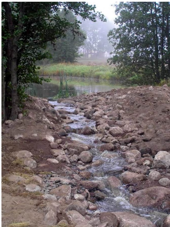
Figur 117. Ramp eller som det också kallas upptröskling som ersatt ett lågt dämme i Sjörydsbäcken, Hjo kommun. Bottenprofilen är v-formad för att fungera såväl vid låg som hög vattenföring. Fotot är taget under konstruktion varför marktäckan ej är på plats. Foto: Erik Degerman.
