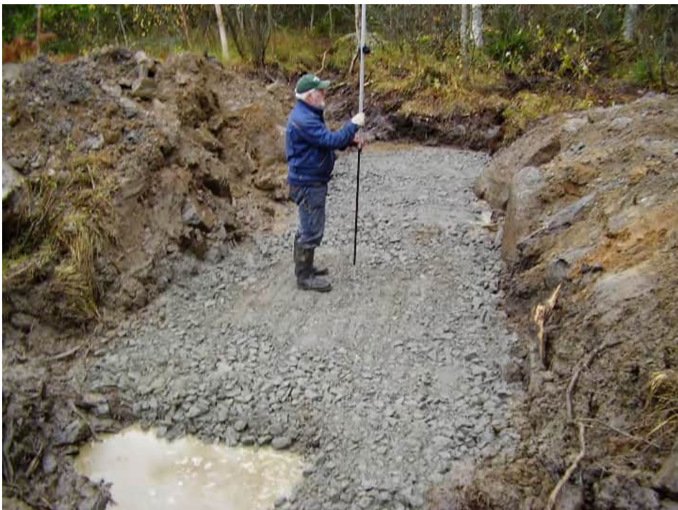
Figur 128. Här har underlaget (stenkross) under vägtrumman kommit på plats och kompakterats. Genom avvägning ser man att det blir rätt lutning (Skärjån, Söderhamns kommun). Foto: Jan Lundstedt.
