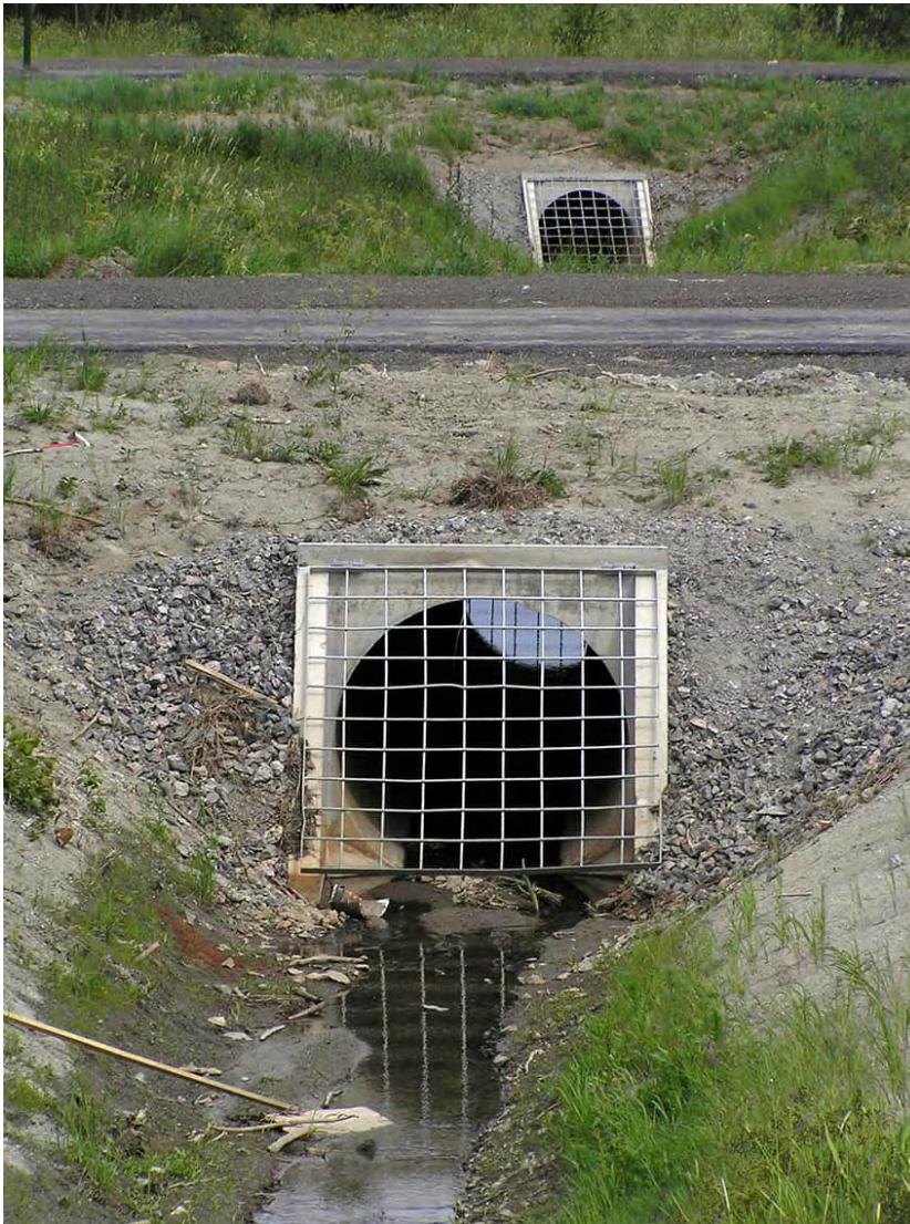
Figur 131. Gallerintag används främst i urbana miljöer, men kan vara ett alternativ i områden med stora mängder drivande grenar och träd. Gallret monteras normalt med en spalt undertill som ger fri passage för mindre föremål och även akvatiska organismer som fisk, men i urbana miljöer vill man främst säkerställa att inte små barn kryper in. Foto: Erik Degerman.
