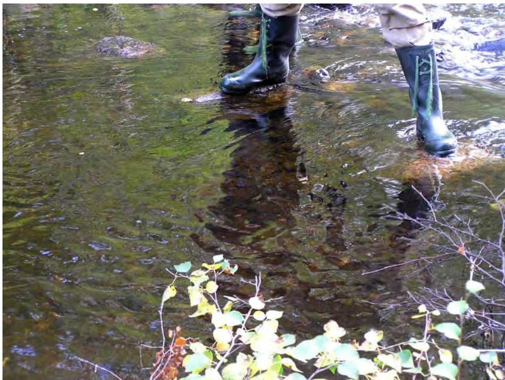
Figur 171. Lekbotten färdigställd. Personen står på de större stenarna som lagts nedströms för att kvarhålla leksubstratet. Dessa stenar läggs i en gles hästskoform nedströms och utmed sidorna. Ibland kan man behöva styra in vatten över lekbotten med hjälp av större sten uppströms. Se till att lekbotten inte ligger så högt att den kan bottenfrysas vintertid. Foto: Erik Degerman.
