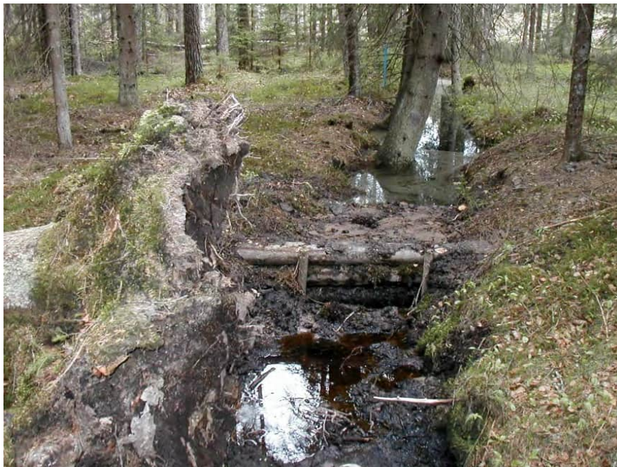
Figur 63. Enkel dikespropp vid rotvälta. Proppen är gjord av massaved och bottensubstrat från diket. En tätning med geotextil, eller hellre lämpligt naturmaterial, gör proppen tät. Livslängden på en sådan propp kan dock vara relativt kortvarig. Foto: Lennart Henrikson.
