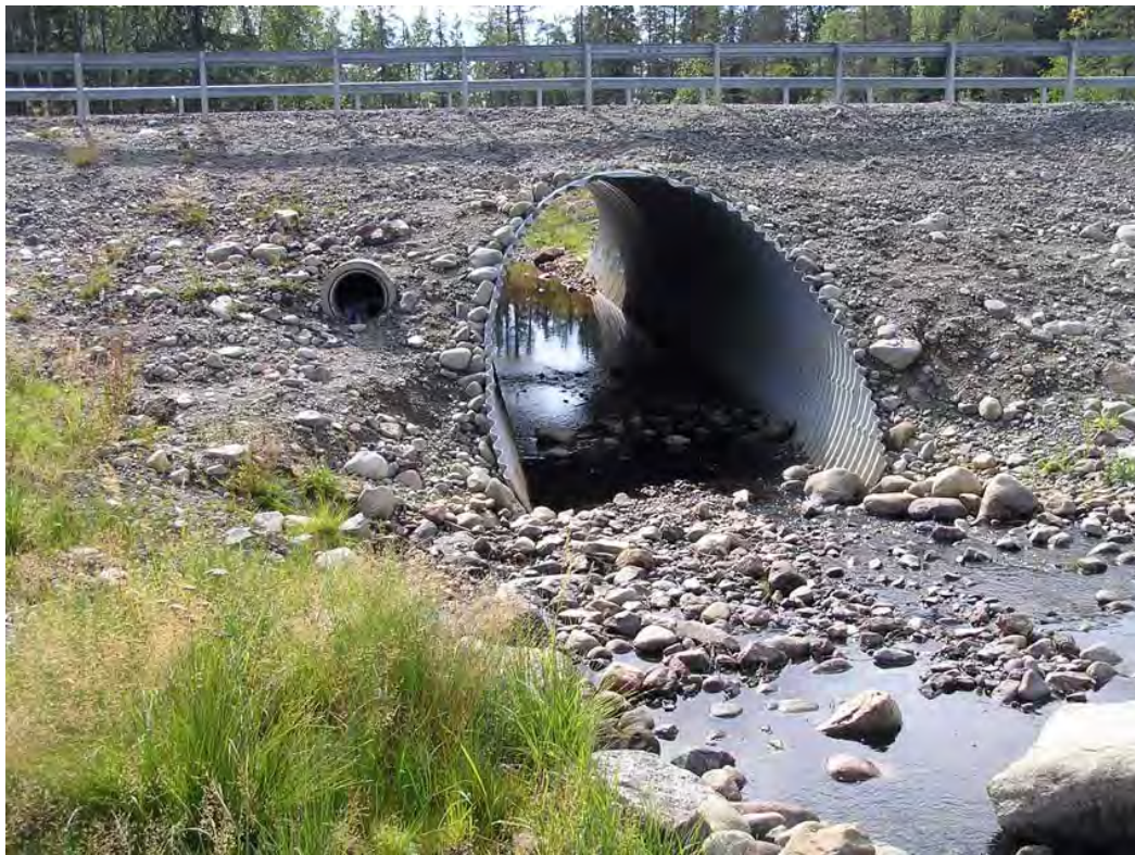
Figur 133. Nedgrävd heltrumma med högre liggande utterpassage i form av en rund betongtrumma i ett biflöde i Öreälvens övre avrinningsområde, Västerbotten. Foto: Erik Degerman.
