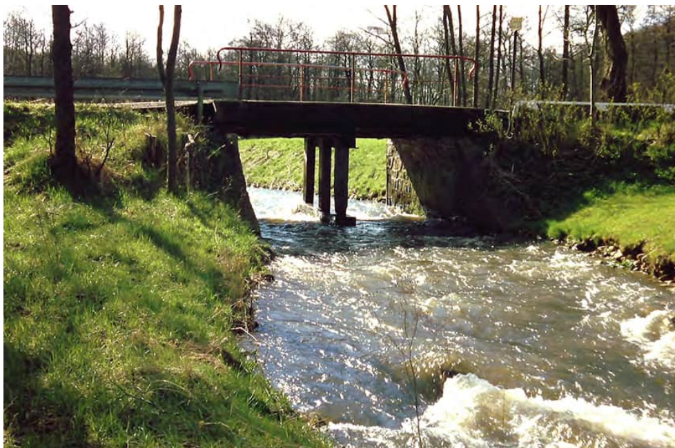
Figur 118. Ett så kallat stryk som etablerats efter att ett dämme rivits bort och ersatts av en bro i Århus å, Jylland. Foto: Erik Degerman.
