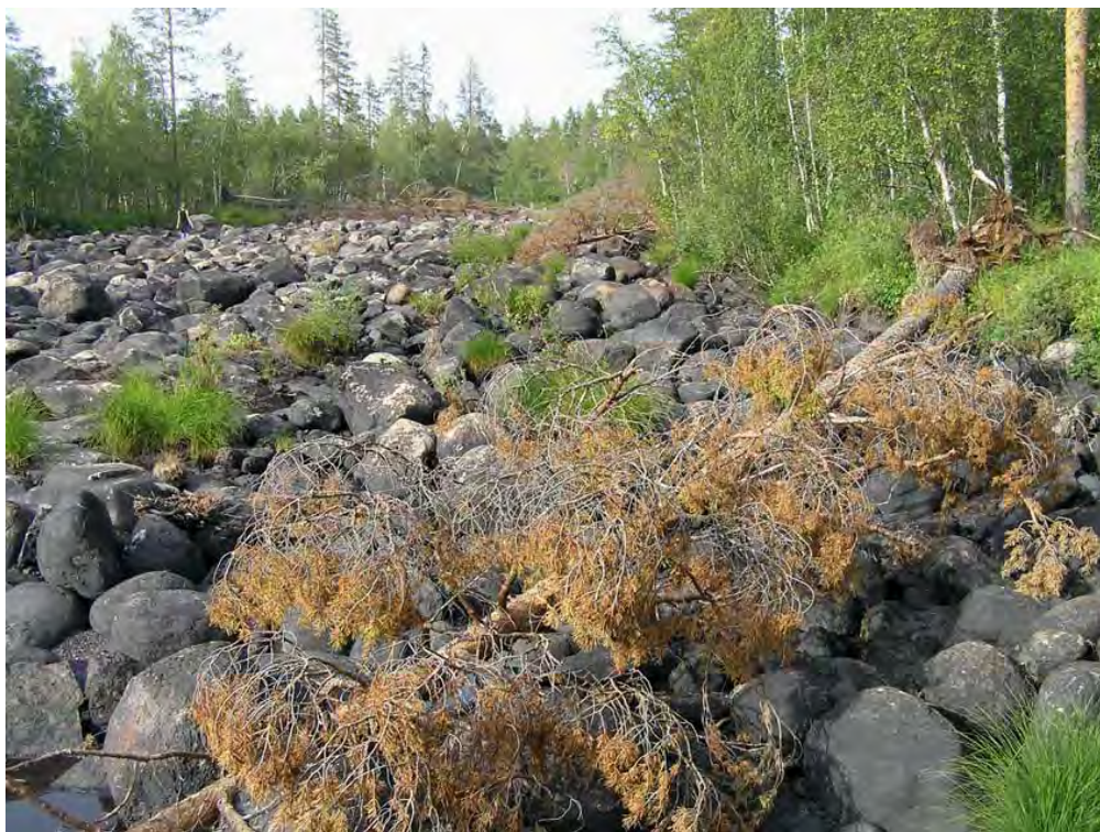
Figur 156. Restaurerad sträcka vid lågvatten där vattenflödet sker under stenarna därför att bottenarna inte tätats med finare material. Detta kommer dock att ske över tid, om inte en damm ligger uppströms och innebär att sediment kvarhålls. Foto: Erik Degerman.
