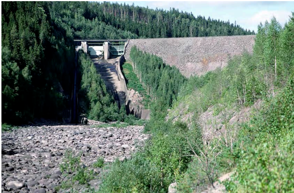
Figur 104. Höljesdammen i övre Klarälven samt del av nedströms torrfåra. Fallhöjden är 88 m och regleringen i dammen styr mycket av kraftproduktionen i de åtta kraftverken nedströms. Laxen kan inte längre nå upp till de övre delarna av älven (Trysilälven) i Norge. Foto: Erik Degerman.
