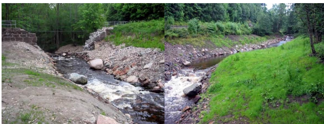
Figur 109. Hökhultsdammen efter utrivning. Efter utrivning blev 1 km ytterligare av Tabergså tillgänglig för vandrande fisk, till exempel insjööring från Vättern. Tätheten av öring har ökat från 5,2 per 100 m 2 till 140 per 100 m 2 två år efter åtgärd. Notera hur stränderna stenkläts för att minimera erosion. Genom stenuläggning i fåran har variation och mindre forsnackar erhållits. Foto: Per Sjöstrand, Jönköpings Fiskeribiologi AB.
